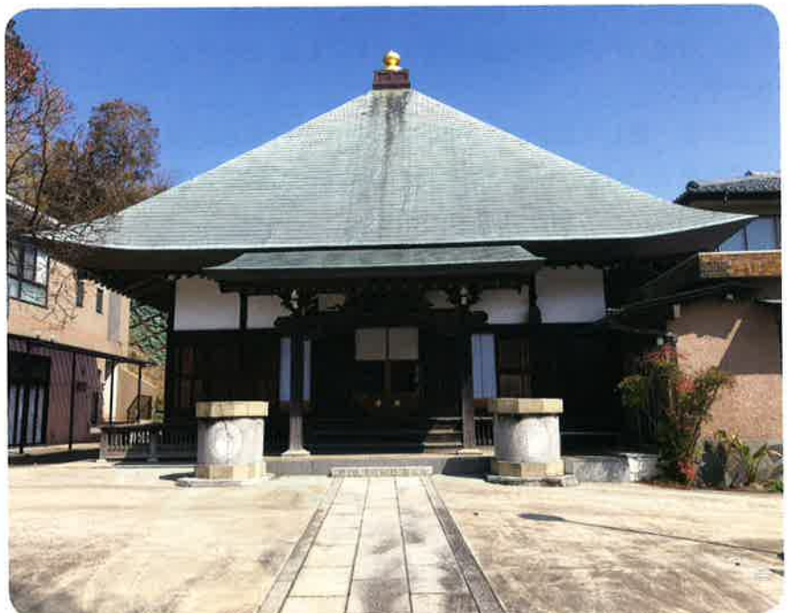
【西勝寺・本殿】
