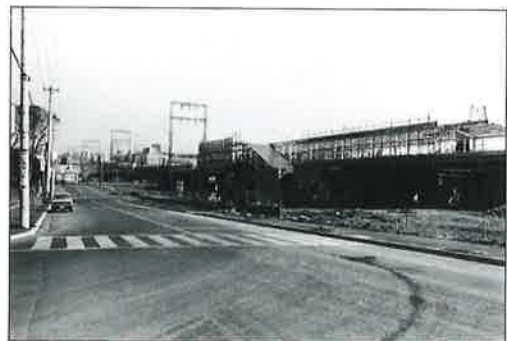
あざみ野駅建設途中(昭和52年) 提供：東急電鉄
