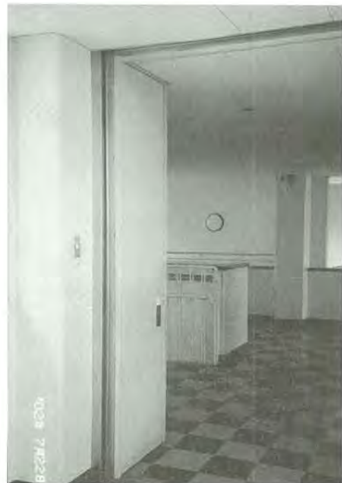
〈防火とびら〉 火が広がらないように とびらがしまります。
