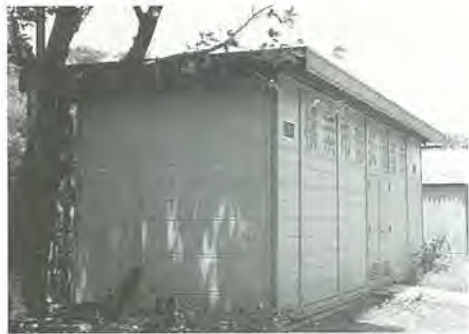
ほうさい び ちく こ 防災備蓄庫
