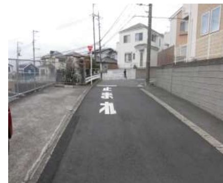
道路全面補修完了事例 101階段付近
