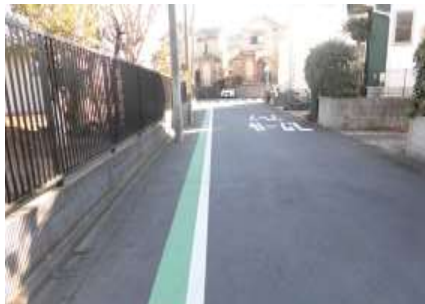
グリーンベルト白線の 引き直し（丘の上保育 園西側通路）
