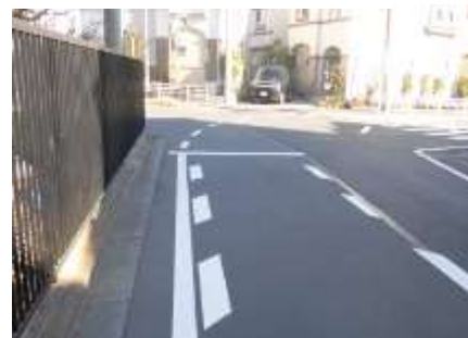
白線の引き直し・一時停止線 引き（丘の上保育園南側側）
