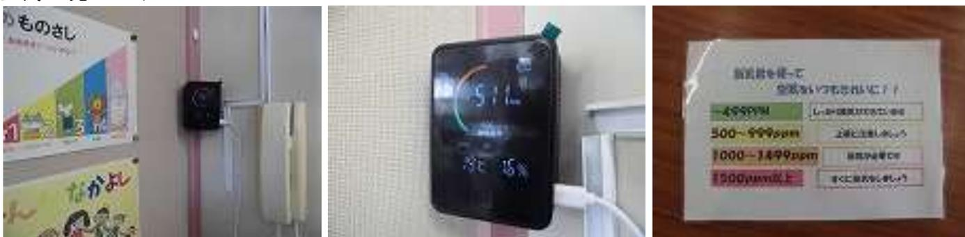
教室に二酸化炭素濃度測定器（CO2モニター）が設置されることになりました。数値に沿って効率的に換気をして教室環境を整えるためです。教室の子ども達もモニターの数字を確認し、基準の1000ppmを意識して窓を開けて空気を入れ替えることができます。きれいな空気を保つための換気の大切さを学び、家庭でも実践できるようになるといいですね。
