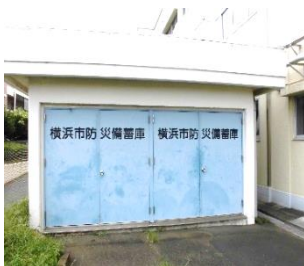
境木小学校防災備蓄倉庫
