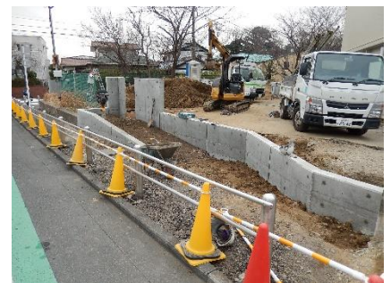
【敷地入口の工事】
