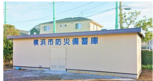
完成間近の防災備蓄庫
