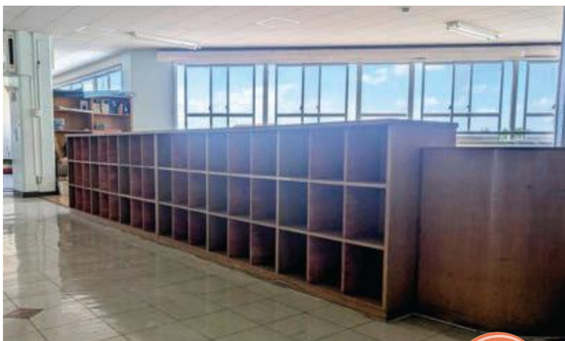
▲施工後の写真
